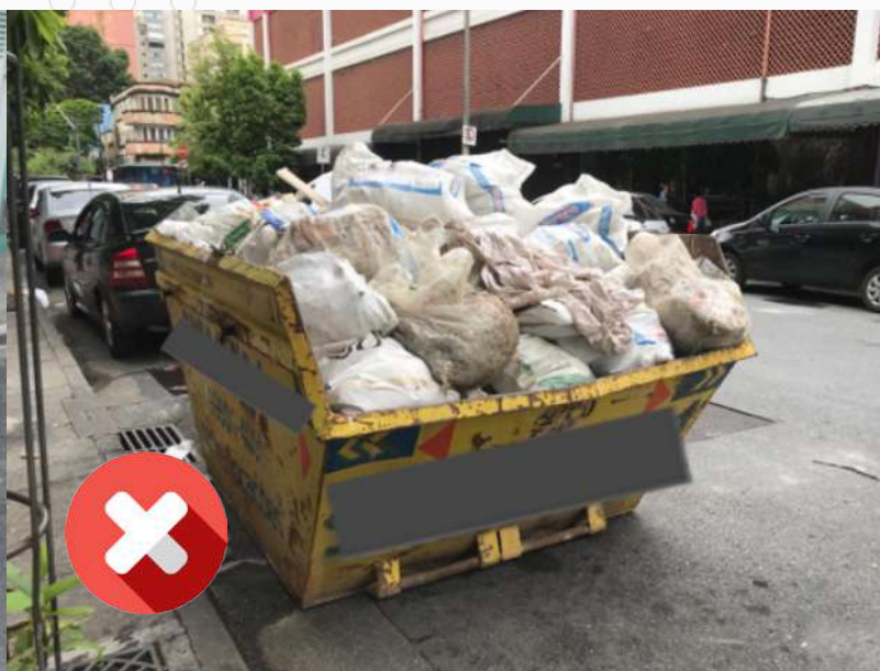
(b) Caçamba preenchida errada, com volume de resíduos acima de sua capacidade.
