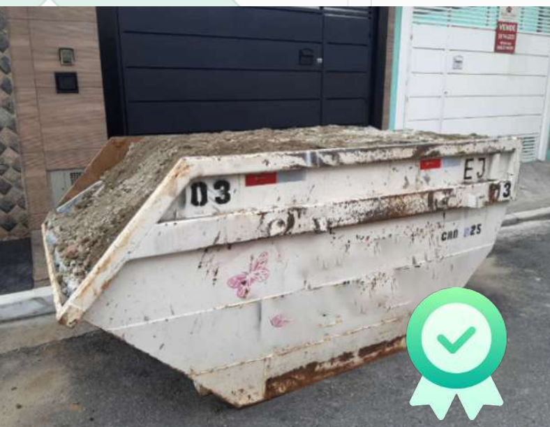
(a) Caçamba preenchida corretamente, volume de resíduos adequado à sua capacidade
