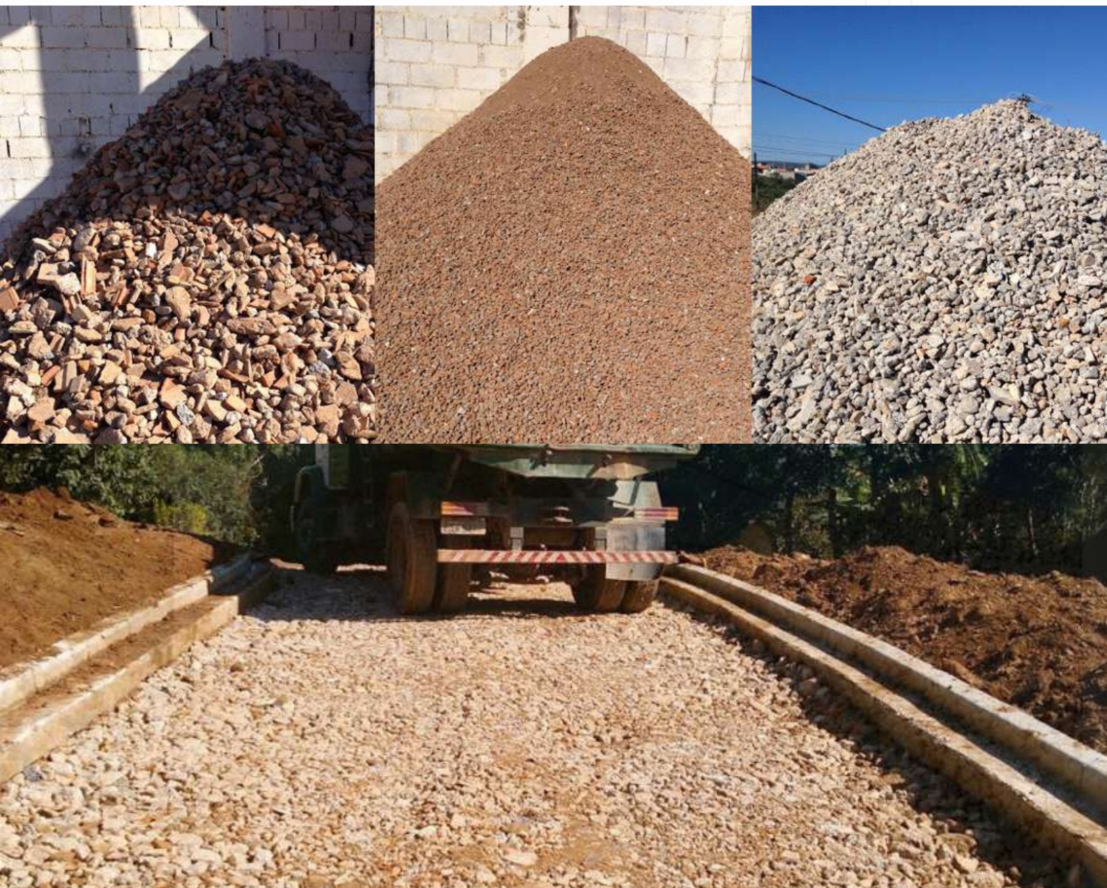
Figura 11 – Fotos ilustrativas dos agregados reciclados mistos (com cerâmica vermelha) e cinzas (com materiais cimentícios) (acima) e sua aplicação em base de pavimentação (abaixo). Fonte: banco de imagem da ABRECON.
